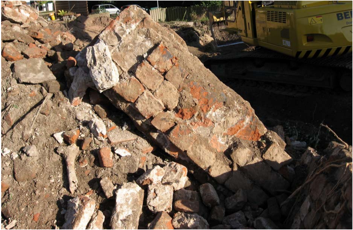
Bij het bouwrijp maken van het terrein aan de Dorpsdijk kwamen grote delen van oude funderingen en muren naar boven, die aanleiding gaven tot verder onderzoek (foto: Johan Hendriks te Lobith).
